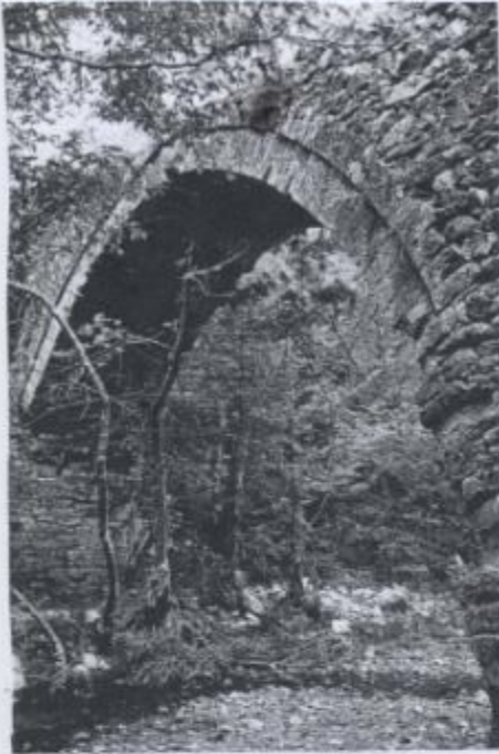
127. Η ανατολική πλευρά του γαβριού της Ντινίτας Αρδο- γαβίου (1995). Η παλαιότητα του γαβριού είναι εμφανής από τις φθορές στις πέτρες και στο συνδετικό κονίαμα.
